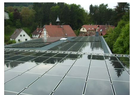
Solarstromanlage in Bensheim-Zell
