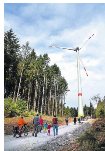
Fertiges Windrad am Greiner Eck (April 2017)
